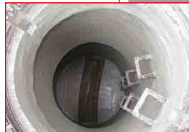
отремонтированный колодец
