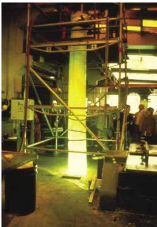
1985 г. Монтаж первого полимерного рукава, отверждаемого УФ-излучением, в г. Ландау (Германия)
