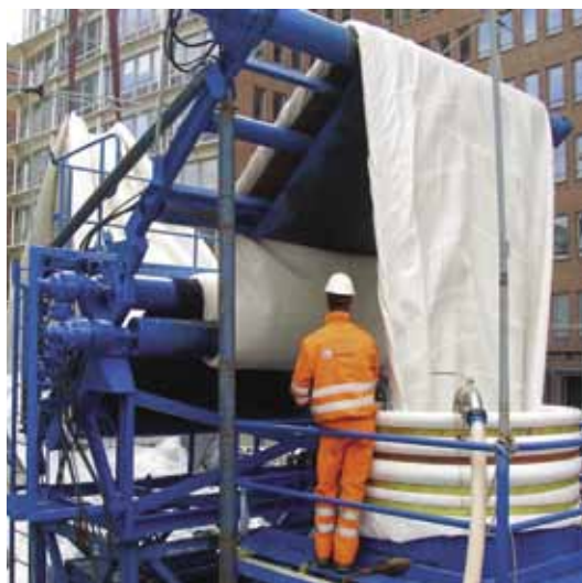
г. Гамбург. Монтаж полимерных рукавов на основе искусственного войлока (пропитка – эпоксидная смола)
