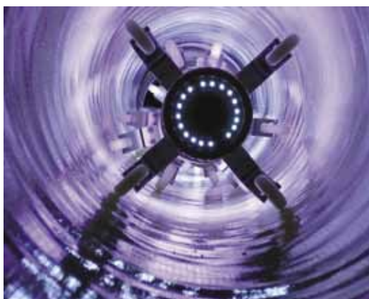
Отверждение полимерного рукава SAERTEX® УФ-излучением
