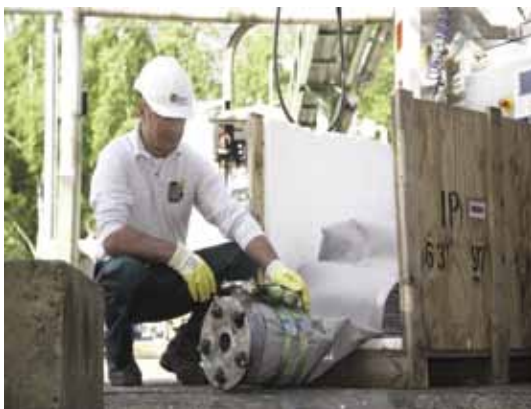
Крепление пакера при монтаже полимерный рукав SAERTEX®
