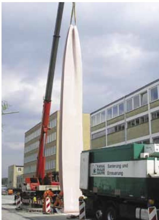
Монтаж рукава фирмой KMG
