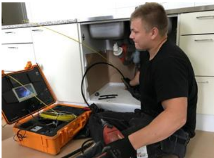
Рис.5. Проведение ТВ-инспекции трубопровода
