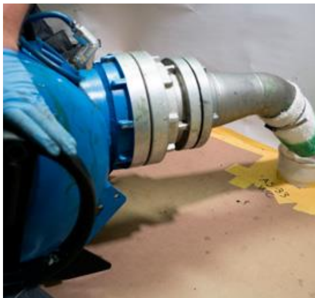
Рис.8. Санация фекальной канализации малого диаметра
