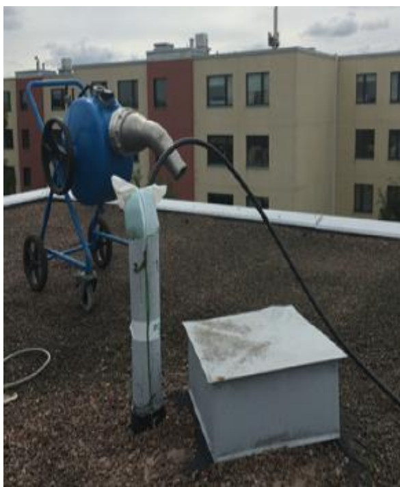
Рис.7. Инверсия рукава BRAWOLINER® с крыши в подвал
