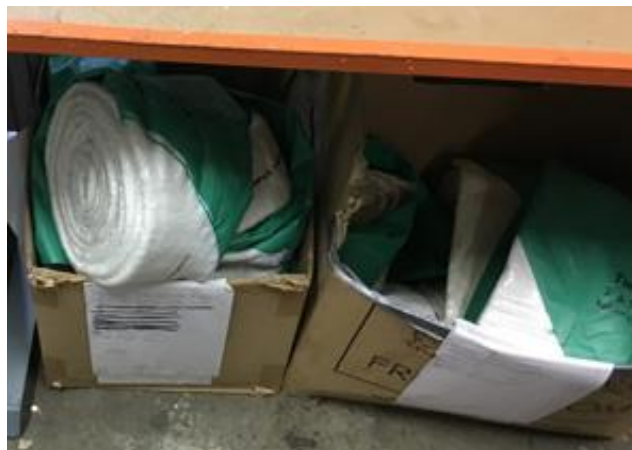
Рис. 6. Подготовленные к монтажу рукава нужных размеров
