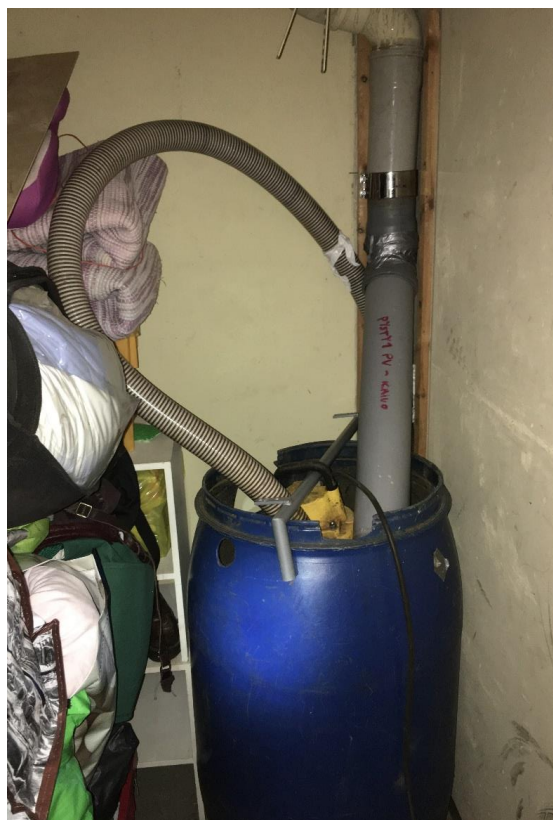
Рис.4. Бочки для сбора твердых веществ при очистке трубопроводов
