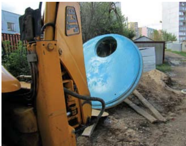
Рис. 12. Монтаж плиты перекрытия
