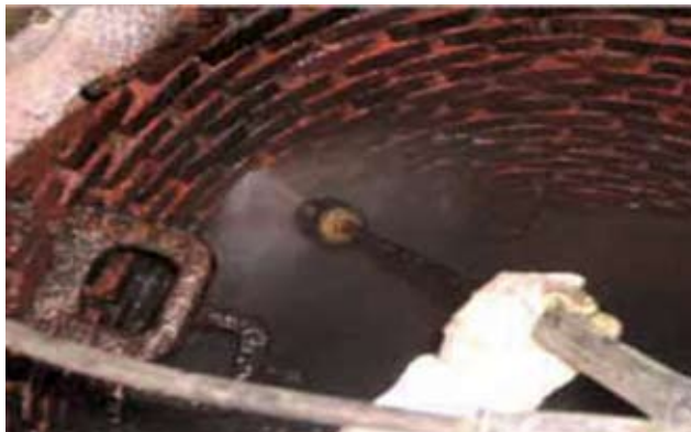
Рис. 2. Водопескоструйная очистка колодца (давление струи 400 – 600 бар)
