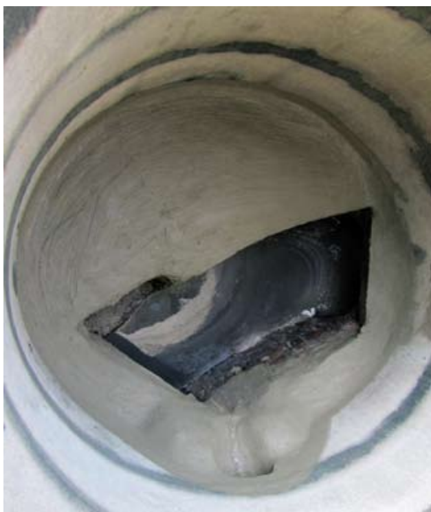
Рис. 9. Камера после репрофилирования и заделки швов
