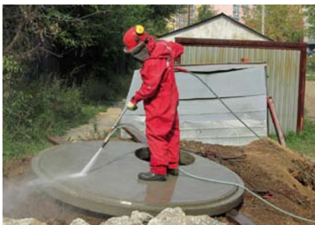
Рис. 9. Камера после репрофилирования и заделки швов
