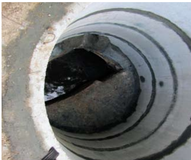
Рис. 7. Внешний вид камеры после монтажа бетонных колец
