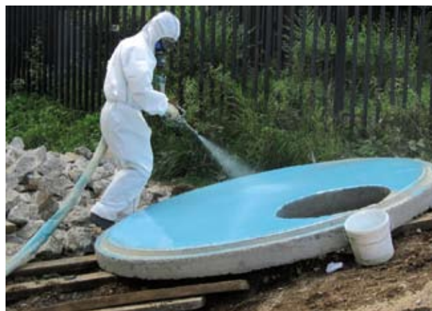
Рис. 11. Нанесение покрытия BASF Oldodur WS 56
