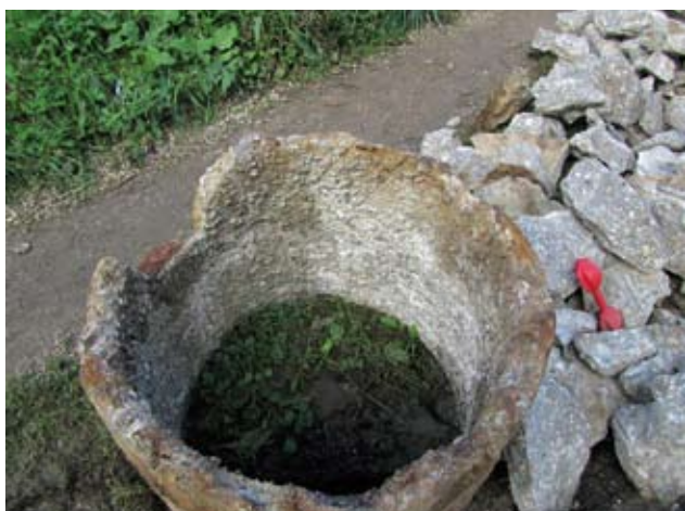
Рис. 9. Камера после репрофилирования и заделки швов
